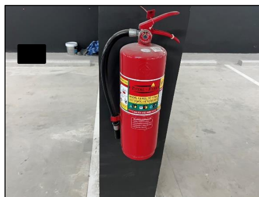
ภาพที่ 31 ถังดับเพลิงและการตรวจสอบ พร้อมป้ายแนะนำการใช้
