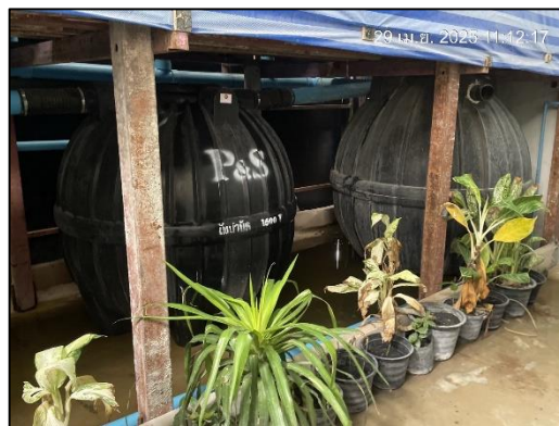
ภาพที่ 11 ถังบำบัดน้ำเสียสำเร็จรูป
